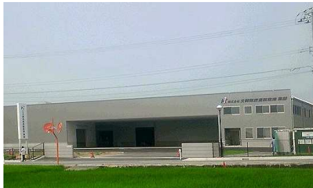
北都黒部 事務所/物流倉庫 (H25.7月 新設)
