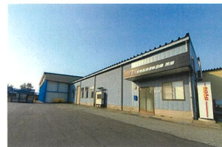
黒部市吉田に新倉庫稼働(R3年4月) (倉庫面積1,730m 2 )
